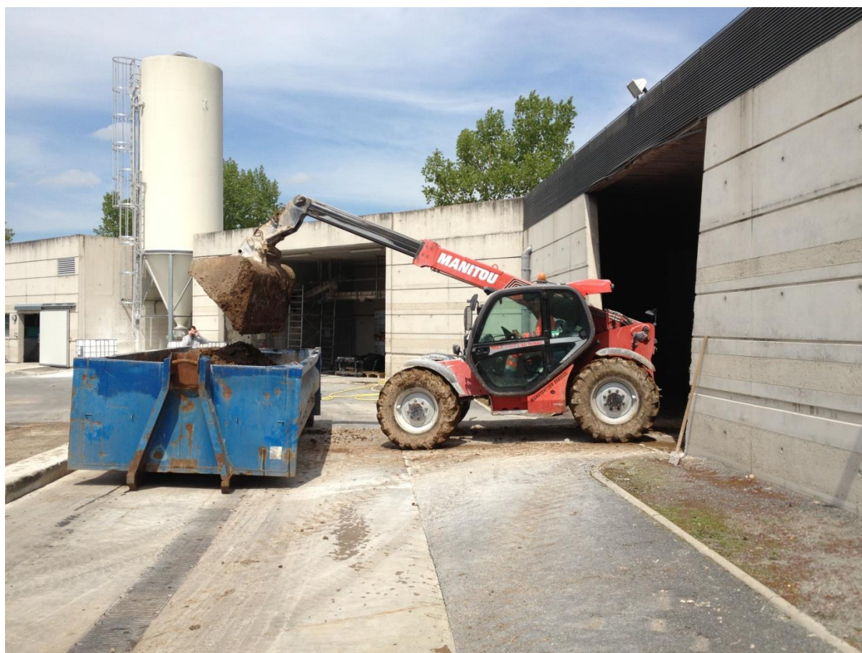
Chargement de boues chaulées en vue d'épandage agricole
