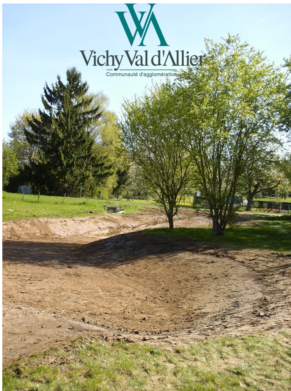
Noue de rétention – Le Vernet
