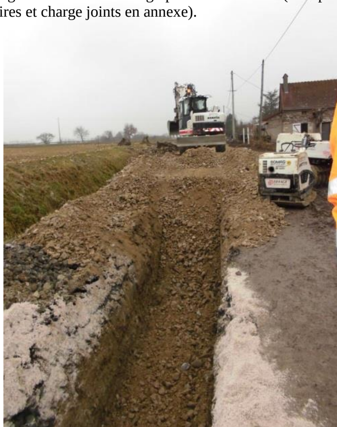
Travaux de suppression des stations d'épuration De Cognat Lyonne et Espinasse Vozelle
