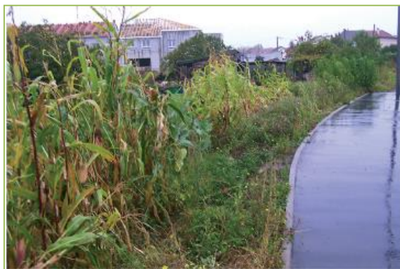
Exemple de noue à Cusset (source : plaquette « Intégrer la gestion des eaux pluviales dans un projet d'aménagement » de Vichy)
