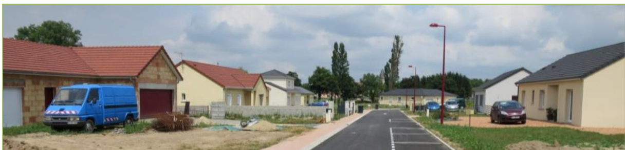
Lotissement rue des roseaux (CDHU)
