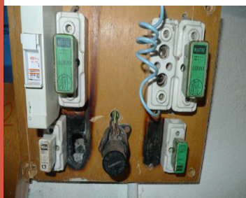
Branchements d'électricité vétustes
