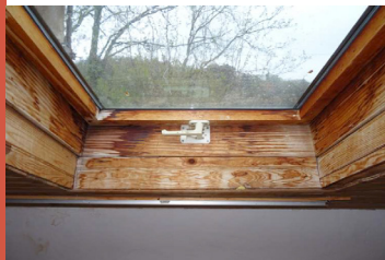
Absence de protection contre les infiltrations d'eau
