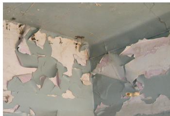
Peinture écaillée contenant du plomb
