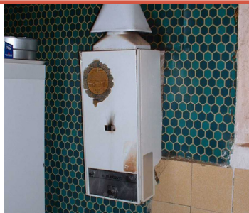
Absence de dispositif d'évacuation des gaz brûlés
