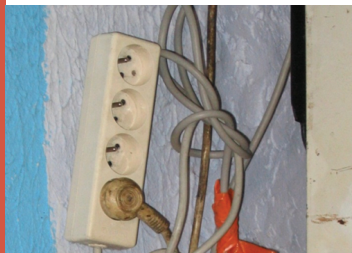
Installation électrique dangereuse
