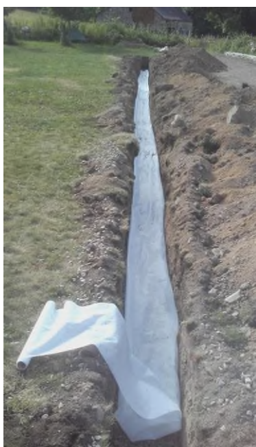
Tranchée d'infiltration
