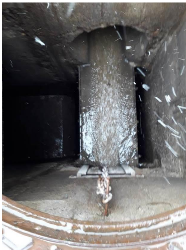
Déversoir d'orage à Saint Germain des Fossés par temps de pluie
