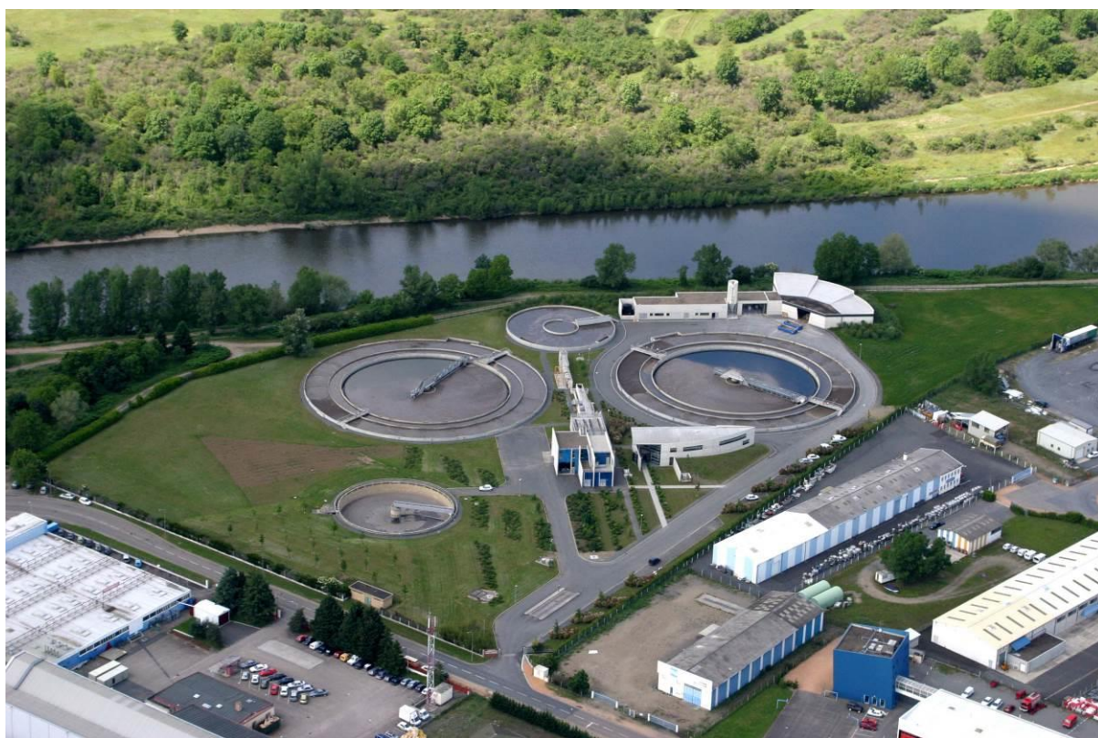
Station d'épuration de Vichy Rhue
