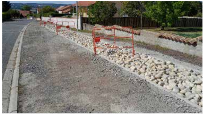
Aménagement d'une tranchée d'infiltration rue des Gourmandes à Creuzier-le-Vieux : Infiltration des pluies courantes, temporisation des pluies d'orage.
