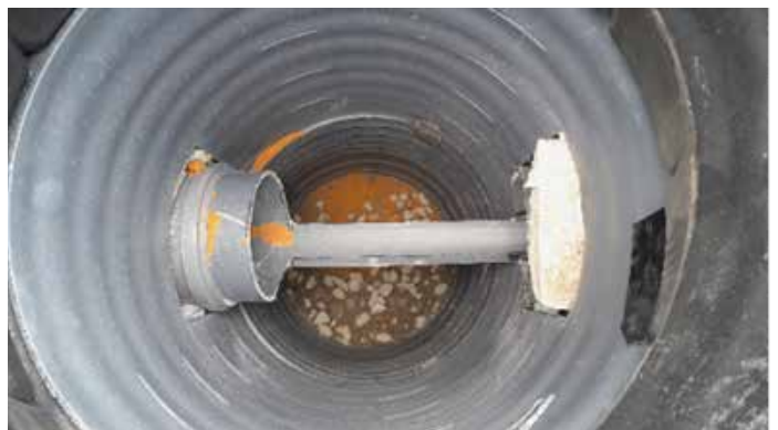
Création de puits d'infiltration rue de la Montée du Loup à Charmeil : Maintien de l'écoulement d'une source, rétention/infiltration des pluies d'orage.
