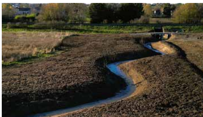
Photo après travaux
