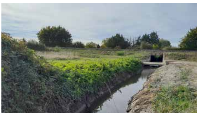
Photo avant travaux
