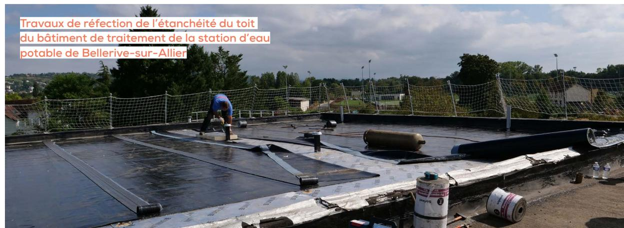
Travaux de réfection de l'étanchéité du toit du bâtiment de traitement de la station d'eau potable de Bellerive-sur-Allier
