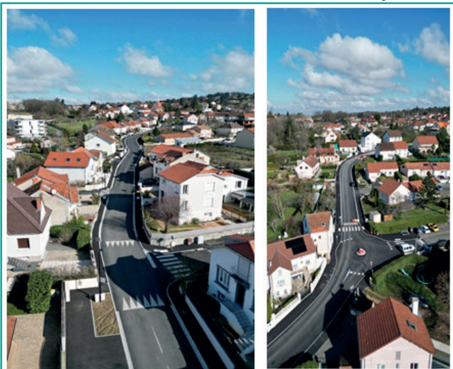
Réfection de la rue de Creuzier - Vichy :
